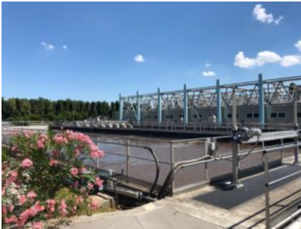
La station d'épuration du Gruppo Cap à Bresso
