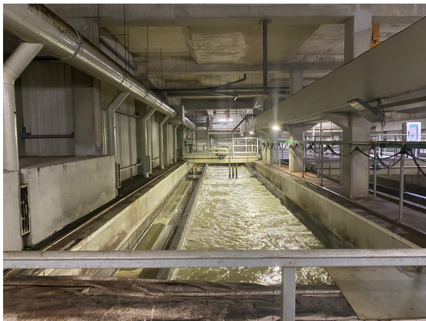
Fábrica de Água de Alcântara
