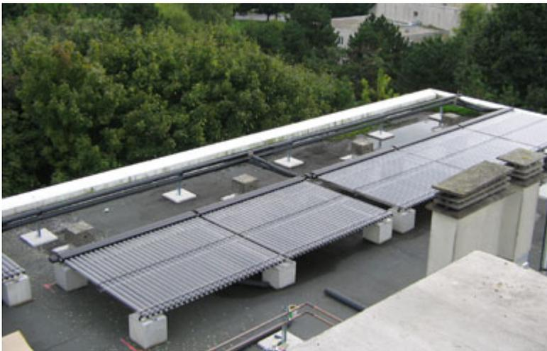
Occupant 158 m<sup>2</sup> sur le toit de la résidence « Les Ecureuils », les 32 panneaux solaires thermiques couvrent environ 30 % des besoins en eau chaude sanitaire des 125 logements. L'appoint est assuré par une chaudière alimentée au gaz naturel.
