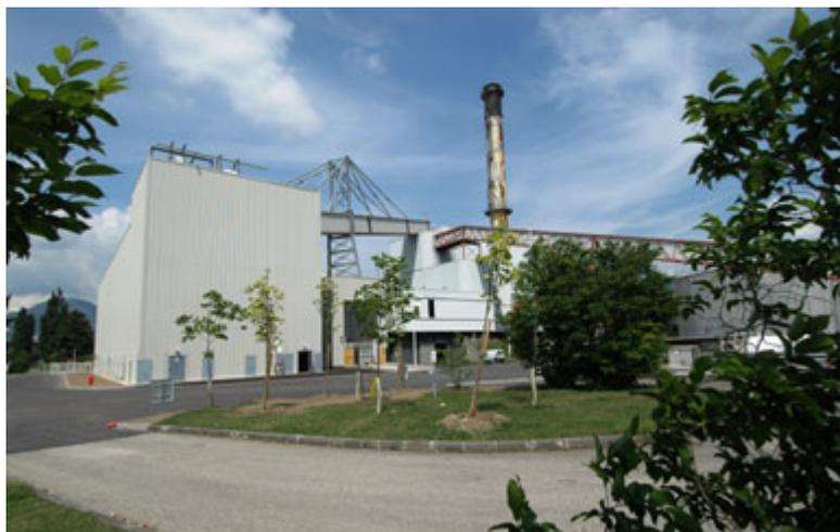
Le site montre un nouveau visage avec la construction d'un silo à bois de 3 000 m<sup>3</sup> permettant de stocker 1 000 tonnes de bois. La chaudière d'une puissance de 63 MW a été adaptée pour brûler en majorité du bois avec un minimum de charbon. A la clé, la chaudière transformée consommant 70 % de bois et 30 % de charbon à pleine charge réduira les émissions de CO<sub>2</sub> de 20 000 tonnes par an et permettra l'économie de 5 300 tonnes équivalent pétrole (TEP) de combustibles fossiles.
